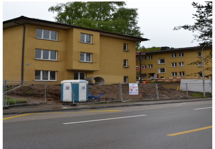
An der Glaubtenstrasse werden Ersatzneubauten erstellt.
