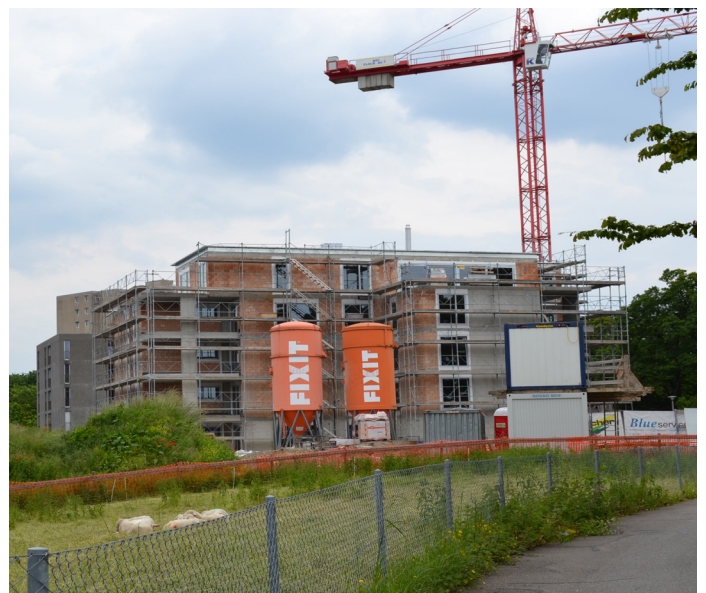
Der Ersatzneubau am Fronwaldweg ist bald fertig.
